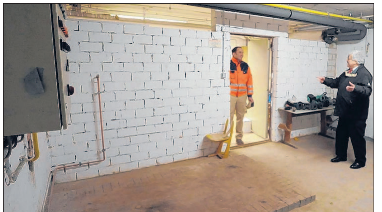
Der Vorsitzende des Schulleiterbeirats Markus Rikart (links) und Bürgermeister Walter Brauer begutachten den ehemaligen Heizraum, der zum Speiseraum werden soll. FOTO: SCHIFFERSTEIN
